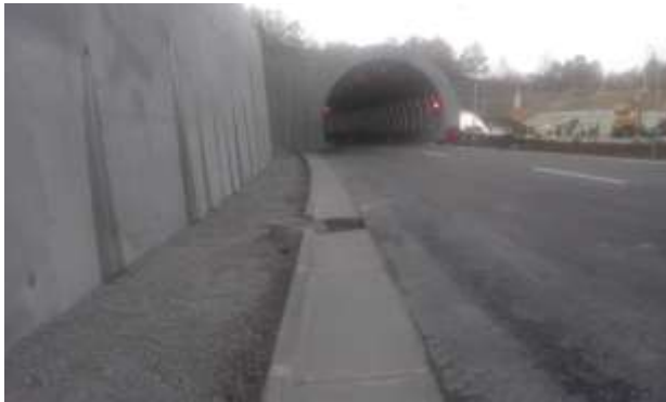
Slika 7. Kanaleta izlaz tunela Šarani sa šaht slivnikom
