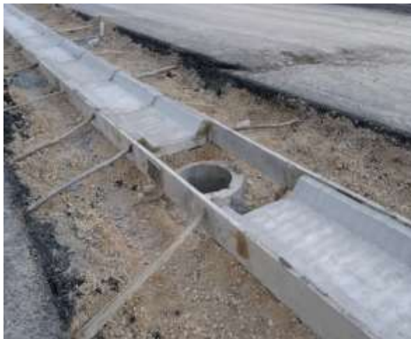
Slika 9. Kanalizacioni šaht slivnik u kanaleti raz. pojasa
