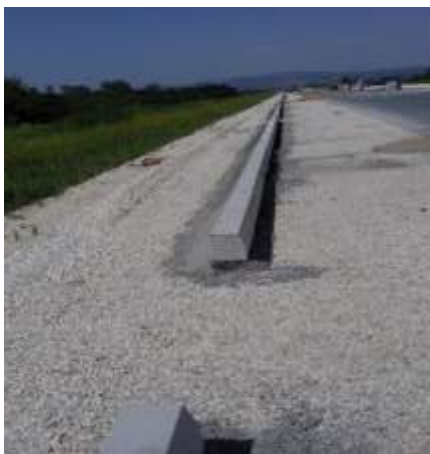
Slika 14. Izgradnja slivnika sa otvorom za bočni izliv Slika 15. Izgradnja otvorenih AB kanala po nožici nasipa
