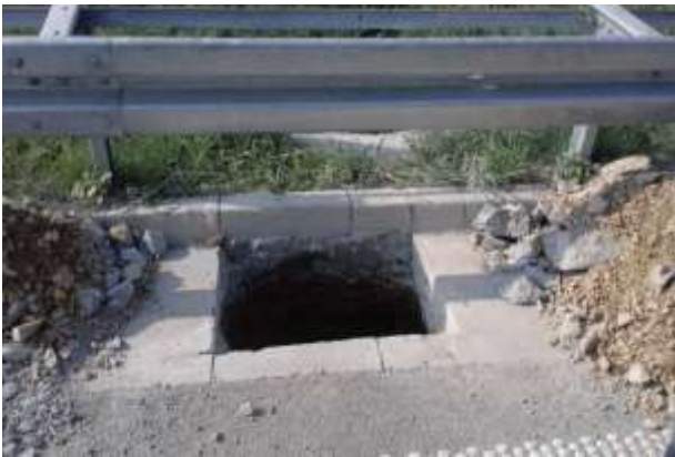
Slika 6. Ugradnja slivničke rešetke
