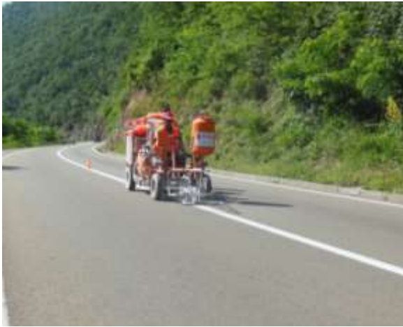
Slika 15. Obeležavanje horizontalne signalizacije
