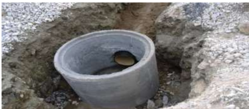
Slika 17. Kanalizaciona cev betonski šaht
