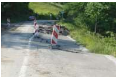
Slika 9. Klizište u Kovačima, IIA 203 na km:9+250 Izvor: Arhiva AD "Novi Pazar – put"
