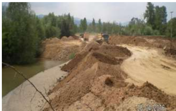
Slika 10. Radovi na sanaciji degradiranog poljoprivrednog zemljišta zoni reke Južne Morave (Foto: V. Popadić)
