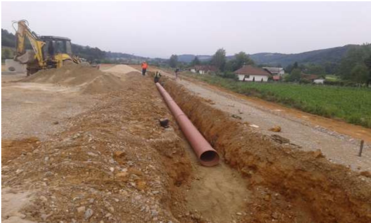
Slika 18. Kanalizacija se postavlja, u bankinama ili u razdelnom pojasu.
