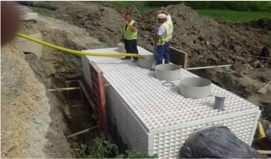
Slika 22. Plastični polietilenski separator. Koridor 11 autoput E 763
