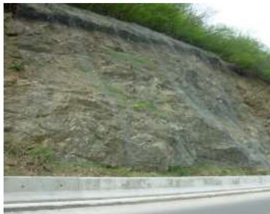
Slika 11. i 12. Nezaštićena i zaštićena kosina na putu IB 22
