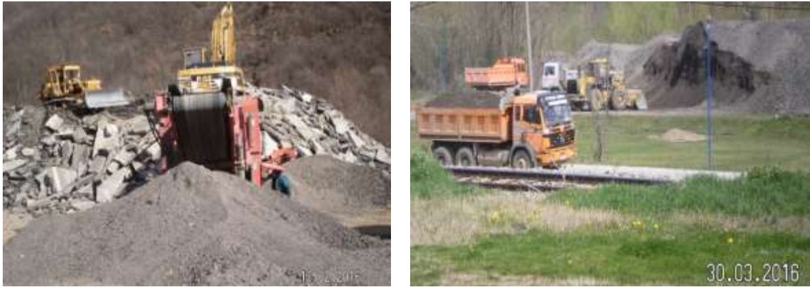
Slika 8. Primer dobre prakse reciklaže i ponovne upotrebe otpadnog asfalta na deonici Grabovnica - Grdelica (Foto: V. Popadić)
