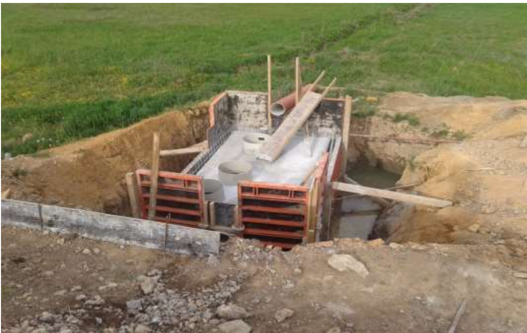
Slika 23. Ugradnja plastičnog separatora u podzemnoj vodi Koridor 11 autoput E 763
