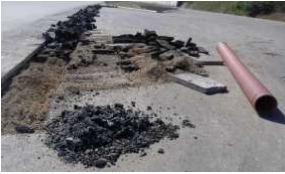
Slika 10. Naknadna izrada odvodnjavanja službenih prolaza Slika 11. Slivnik u eksploataciji
