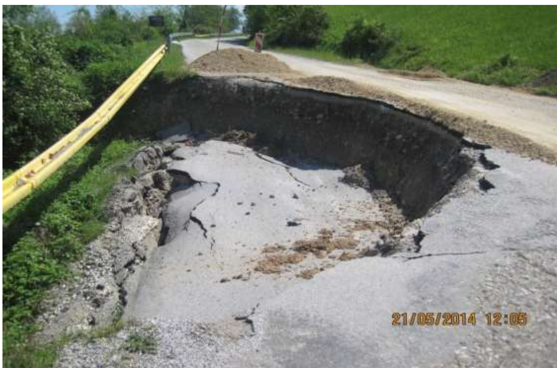
Слика 6. Клизиште на државном путу IIA-170, деоница: Ваљево – Дебело брдо, km:22+200, настало након мајских поплава 2014.год.
