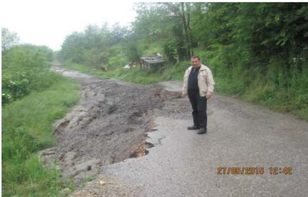
Слика 10. Клизиште на државном путу IIB-342 Ваљево (Иверак) – Караула - УБ, km: 3+610 у насељу Дупљај.
