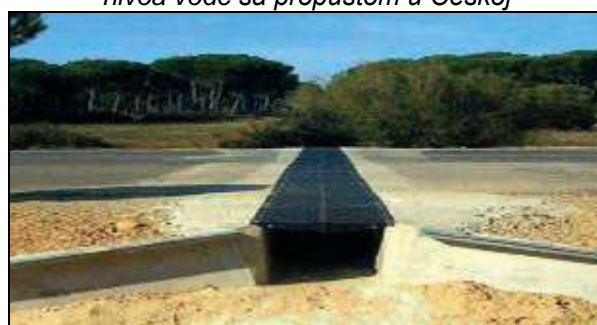
Slika 7. Tunel za vodozemce sa otvorenom mrežom na putu u Španiji
