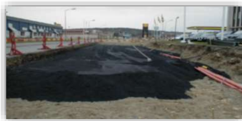
Slika 2. Rekonstrukcija ulice korišćenjem granulirane šljake - Boliden Iron Sand u Švedskoj [3]
