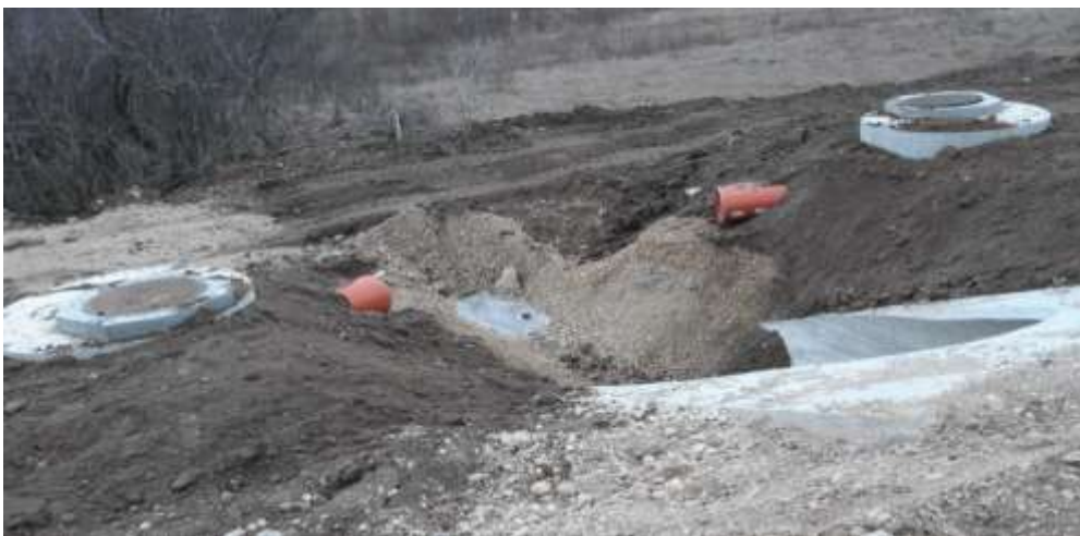
Slika 25. Detalj izliva dva separatora i cevastog propusta.
