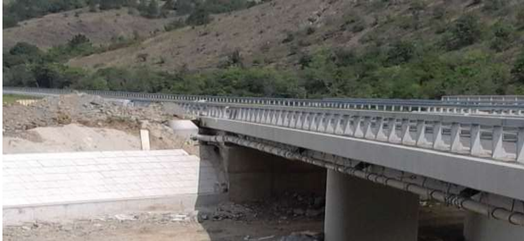
Slika 26. Na delu ispod ploče mosta cevovodi ce kače na konstrukciju mosta vešaljka.
