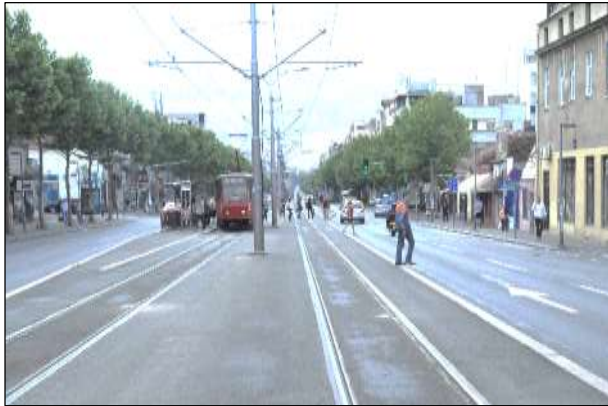
Слика 3. – Неодговарајуће вођење пешачких токова
