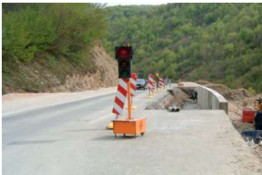
Slika 7. Sanacija klizišta na putu IB 22 Novi Paraz - Ribarići
