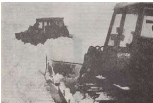
Slika 18. Buldozer na probijanju smetova
