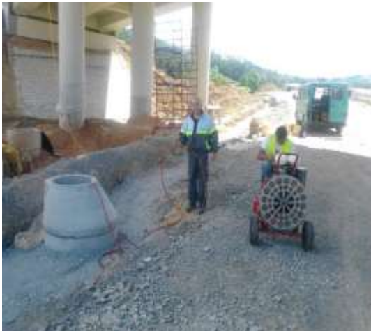
Slika 16. Ispitivanje vododrživosti – nepropusnosti kanalizacionih cevi vazduhom
