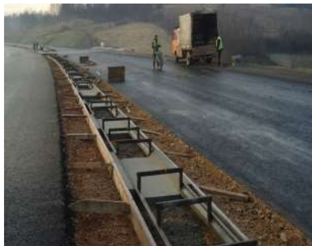
Slika9. Izrada kanalete u razdelnom pojasu
