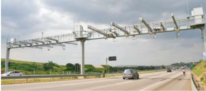
Slika 3. Sistem elektronske naplate putarine baziran na višetračnom slobodnom protoku vozila Izvor: www.vonbraunlabs.com
