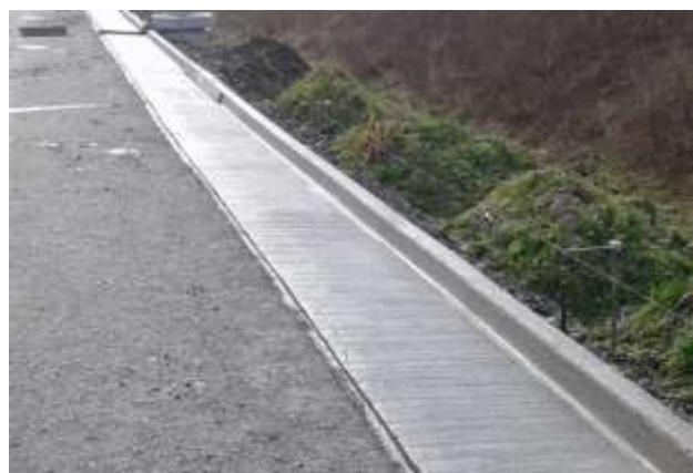
Slika 5. Mašinski izgrađena rigola sa slivnikom
