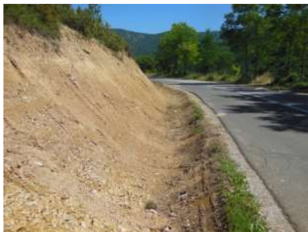
Slike 13. i 14. Dobro i loše održavanje sistema odvodnjavanja
