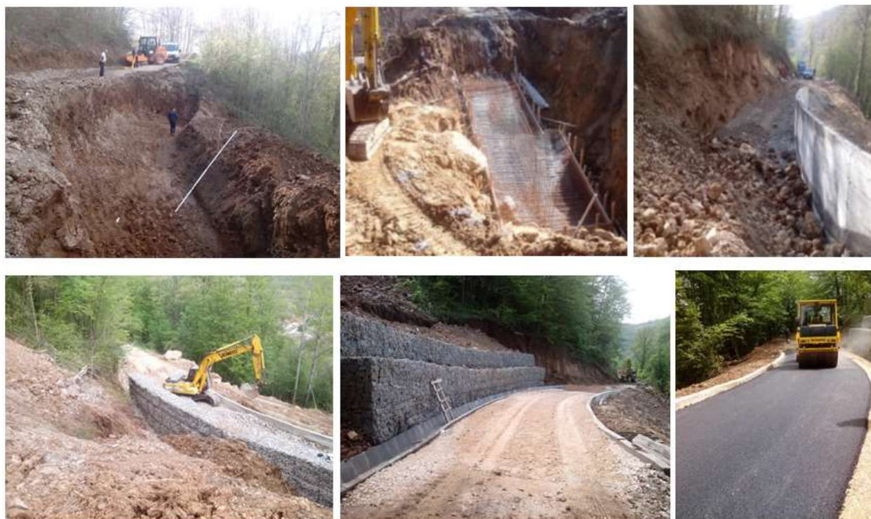
Slika 3. Radovi na sanacijama klizišta u 2017. Klizište na nekategorisanom putu Ljuberađa - Berduj (opština Babušnica) - potporni zid i gabionska konstrukcija
