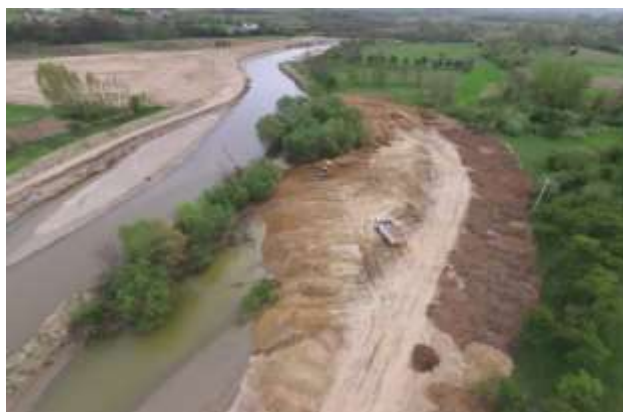
Slika 12. Sanacija degradiranog zemljišta u zoni reke Južne Morave, viškom zemljanog materijala iz iskopa sa deonice Manajle (tunel) - Vladičin Han
