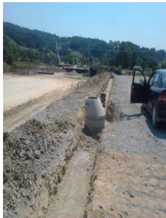
Slika 19. Kanalizacija i drenaža u razdelnom pojasu detalj / Izvođenje
