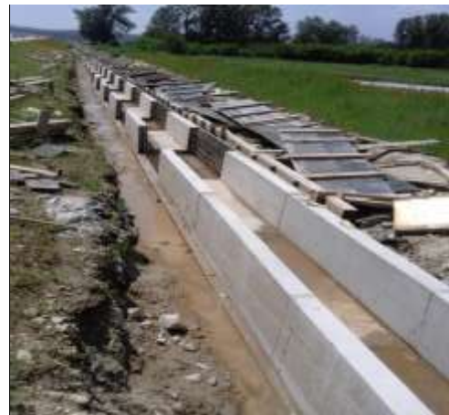
Slika 14. Izgradnja slivnika sa otvorom za bočni izliv Slika 15. Izgradnja otvorenih AB kanala po nožici nasipa
