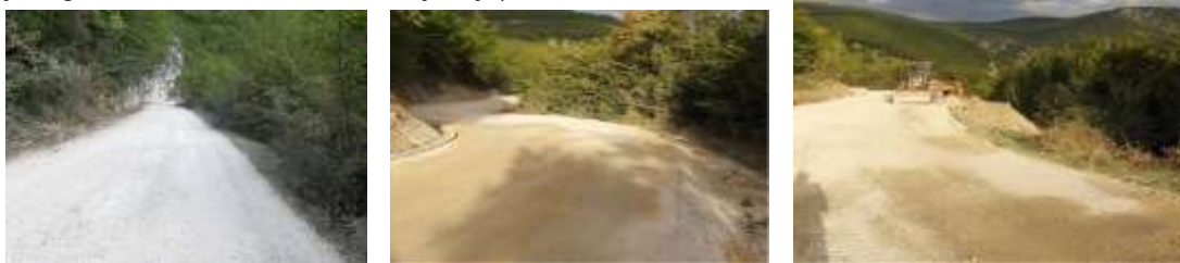
Slika 5.6.7. Državni put IIA 204 u fazi gradnje, deonica Sopoćani - Crnoča Izvor: Arhiva AD "Novi Pazar – put"
