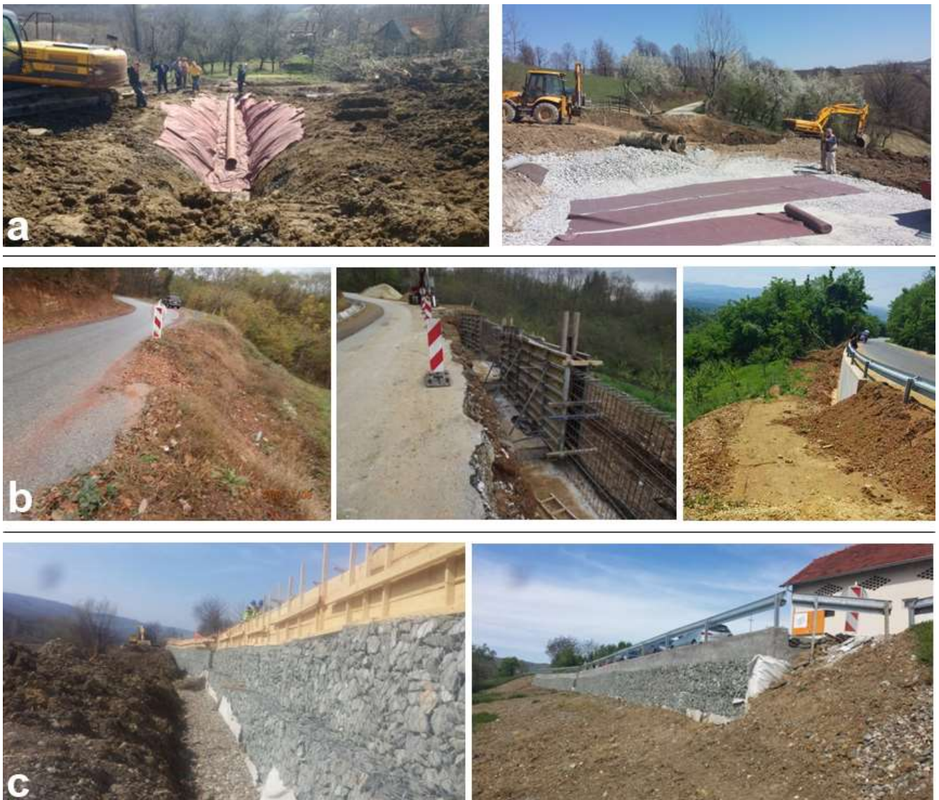
Slika 2. Radovi na sanacijama klizišta u 2017. a) Klizište Gonja Crnuća - drenažni radovi; b) Klizište na putu Toponica-Sumorovac - potporni zid; c) Klizište Levići – gabionska konstrukcija
