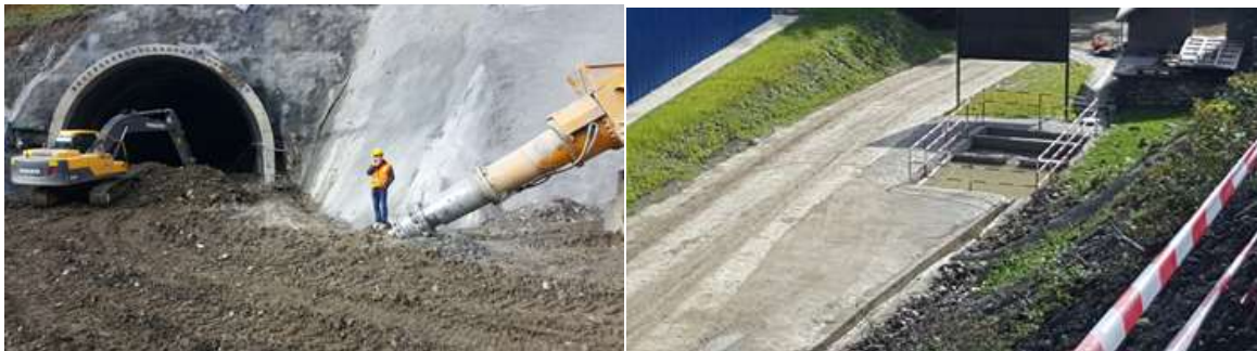
Slika 3a i 3b. Sjeverni portal tunela Jabučki krš (autoput Bar-Boljare, dionica Smokovac-Mateševo) Izvor: E3 Consulting
