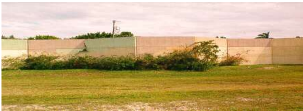
Slika 10. Primer loše održanih bojenih zidova
