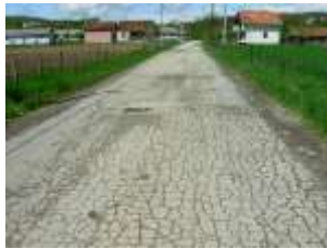
Slika 13. Loš asfalt na putu Državni put IIA reda broj 202 Izvor: Novi Pazar – put d.o.o. arhiva
