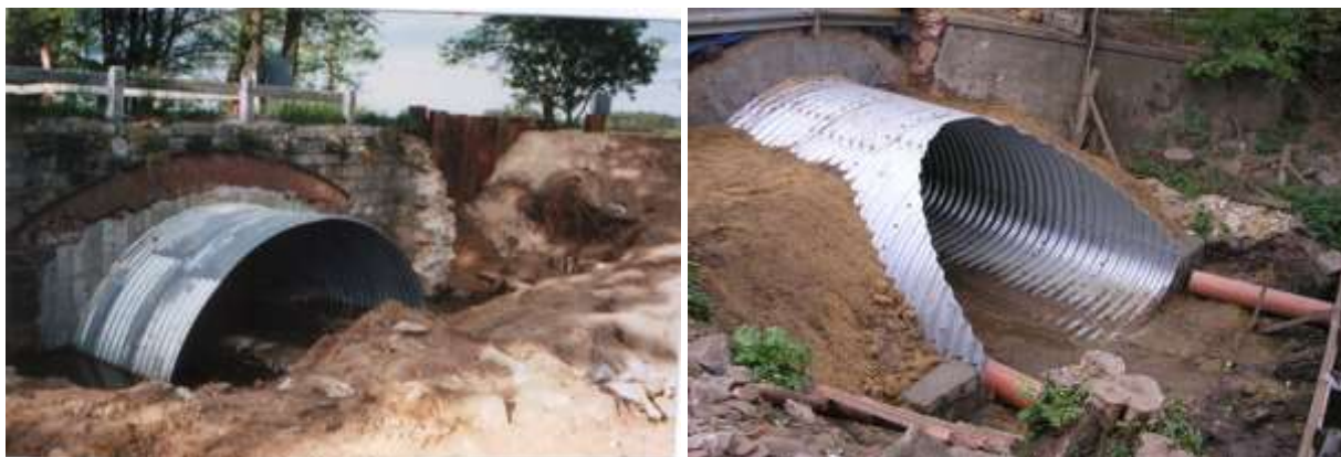
Slika 9. i 10. Primjer rekonstrukcije nadsvodjenog prolaza od opeke zbog proširenja
