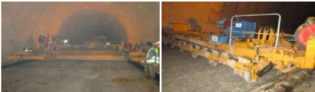
Слика бр.5: Постављање финишера на шине вођице
