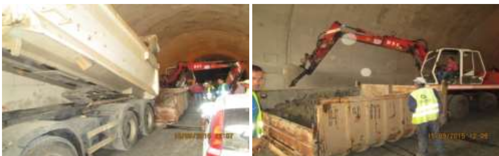
Слика бр.6: Истовар свежег бетона у бокс
