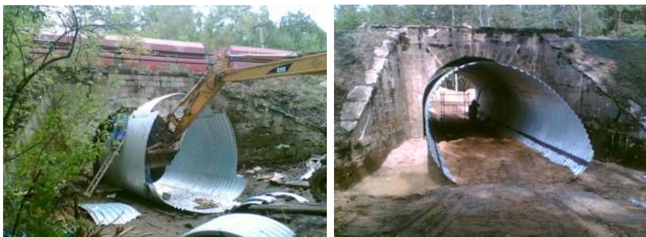
Slika 3. i 4. Primjer rekonstrukcije AB prolaza iz Poljske
