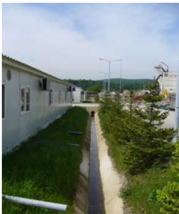
Slike 4. i 5. Odvodnjavanje atmosferske i otpadne vode u kampu Izvođača radova (Izvor, autor teksta)
