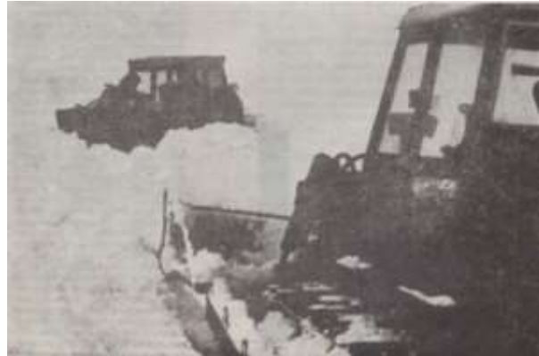
Slika 2. Buldozeri na probijanju smetova
