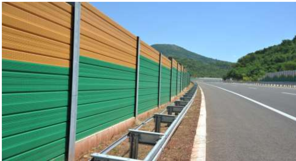
Slika 3. Izgled zida za zaštitu od aluminijских panela, Koridor X, Srbija (Fotodokumentacija Institut za puteve a.d.)
