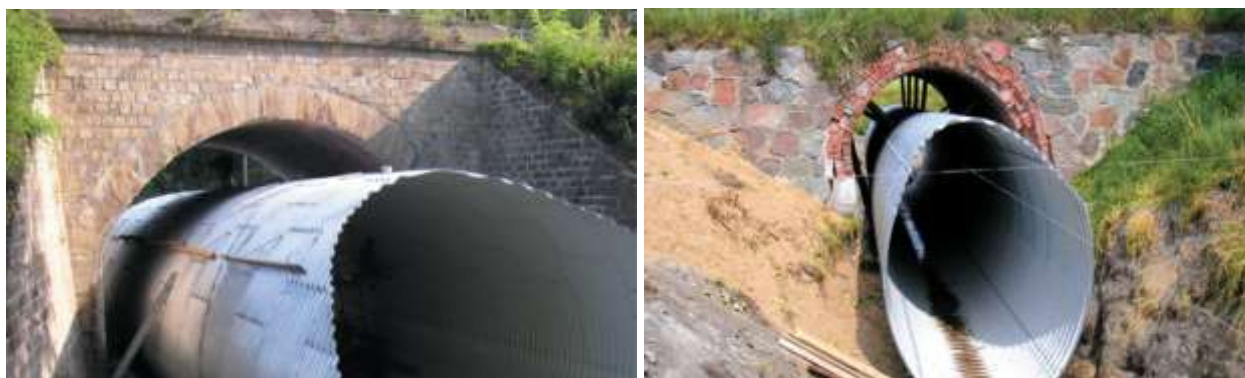
Slika 7. i 8. Primjer rekonstrukcije nadsvodjenog prolaza od opeke iz EU zbog proširenja
