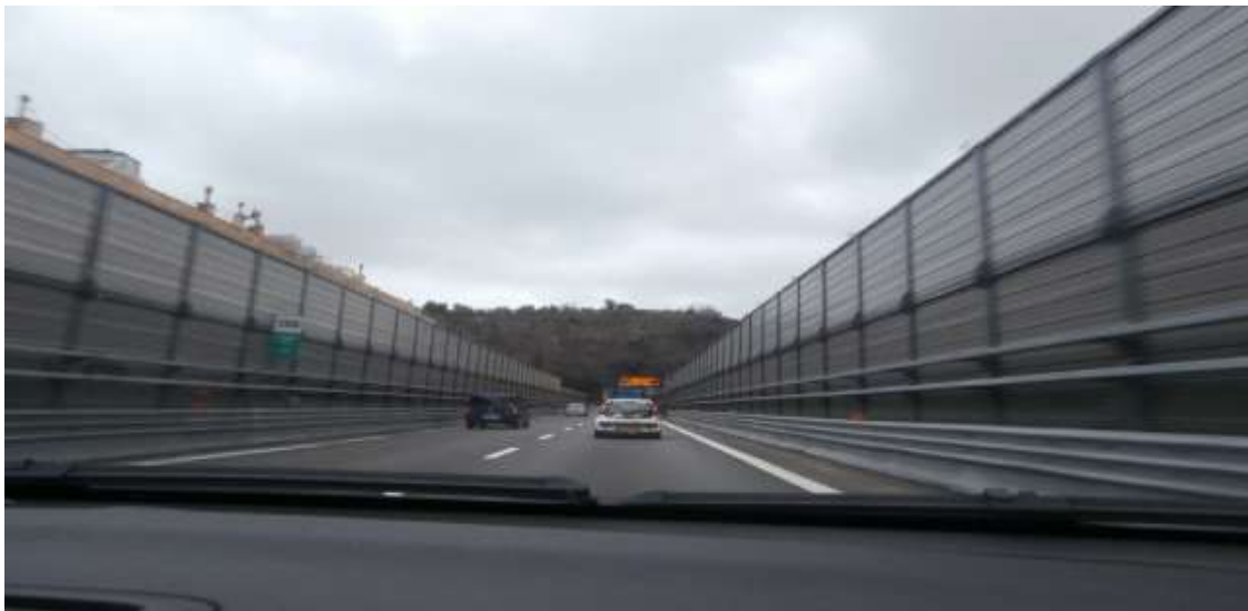
Slika 9. Primer obostrano postavljenih zidova, efekat tunela (Autor rada)
