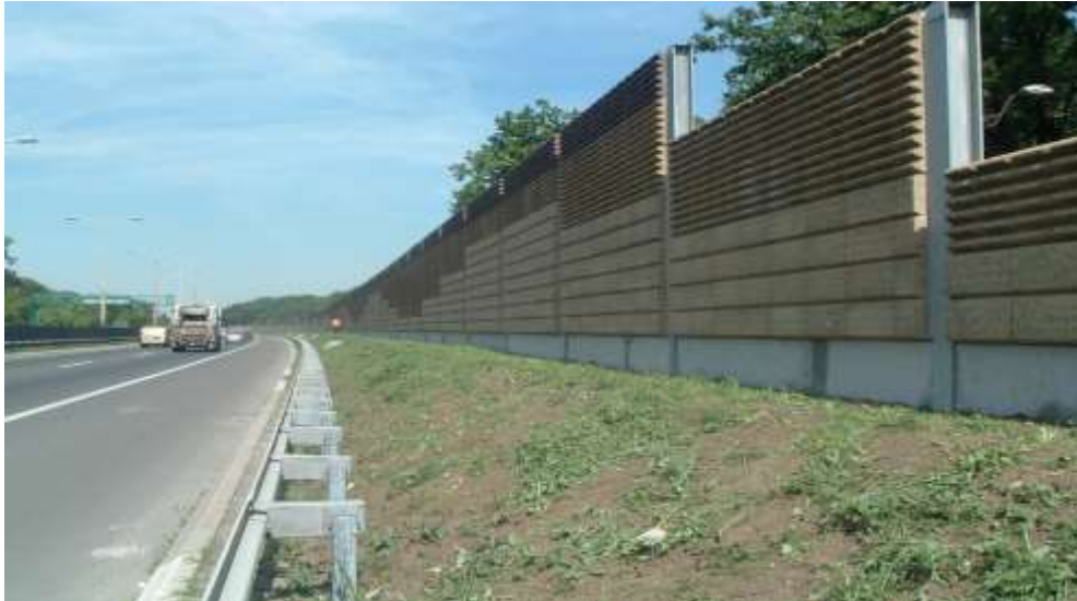
Slika 2. Izgled zida za zaštitu od buke od lakog betona, Beograd ( http://beobuild.rs )
