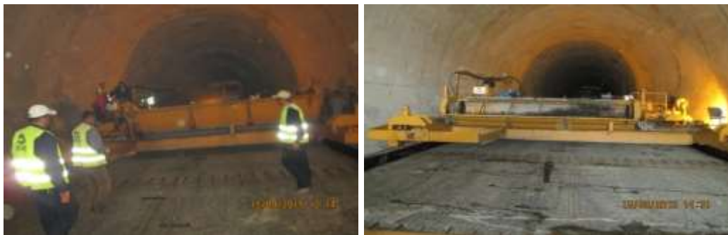
Слика бр.7: Положај разасираща за рад у тунелу
