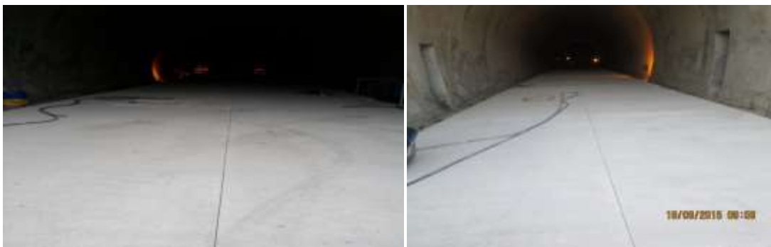
Слика бр.9: Спојнице на бетонском коловозу
