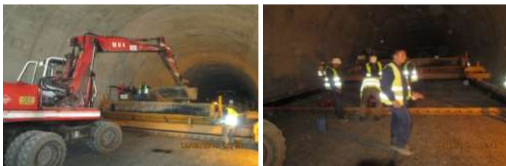
Слика бр.8: Утовар бетона у разасиращач на припремљеној дужини од 24 метра
