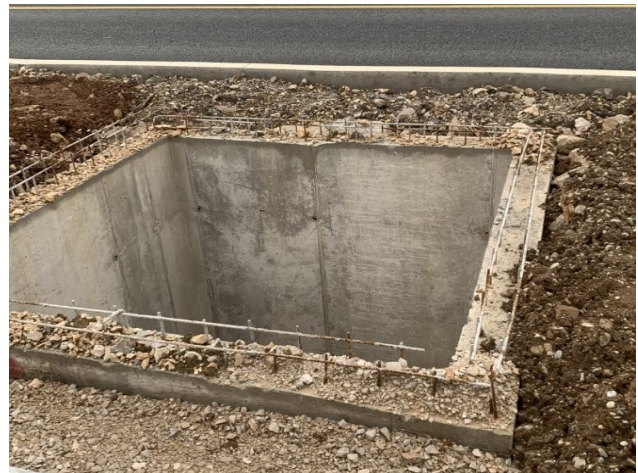
Slika 9. Izgradnja otvora za svjetlost na prolazima za životinje Izvor: E3 Consulting
