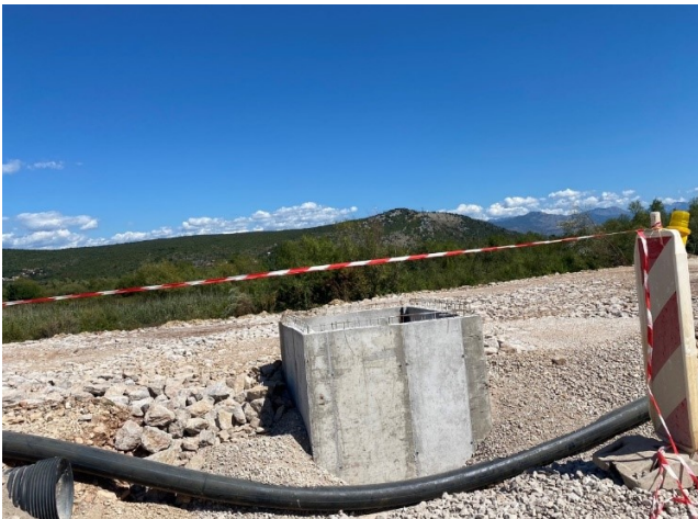
Slika 9. Izgradnja otvora za svjetlost na prolazima za životinje Izvor: E3 Consulting
