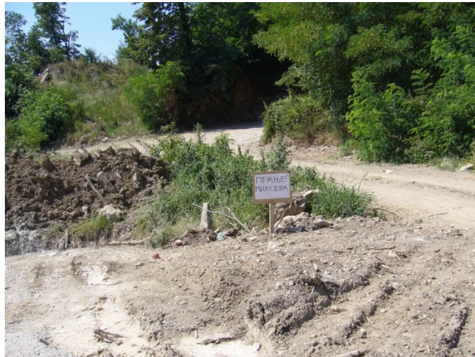
Слика 4 - Пример импровизације ископа јаме за прање миксера на локацији моста бр. 14, Деоница Лајковац - Љиг
