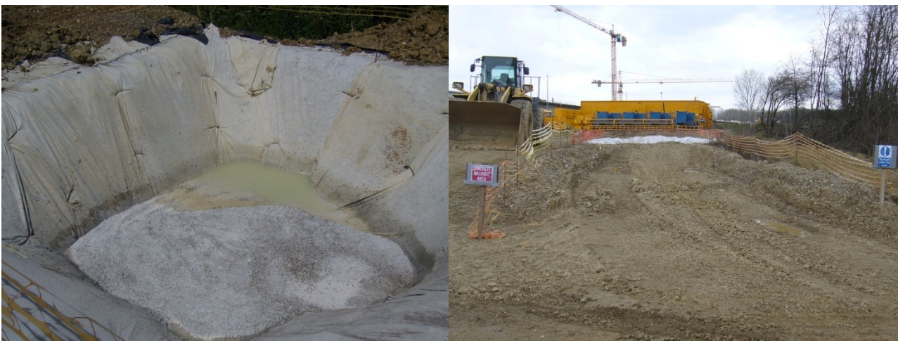
Слика 10 и 11 - Прописно урађена, заштићена и обележена јама за одлагање вишкова бетона из миксера – деоница аутопута у изградњи Кузмин – Сремска Рача
