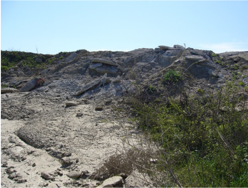
Слика 6 - Веома честа појава на свим деоницама изградње аутопута – пример одбацивања вишка бетона после бетонирања објеката на траси аутопута (насип реке Тамнаве у непосредној близини деонице Обреновац - Уб, Сектор I аутопута Е – 763).
