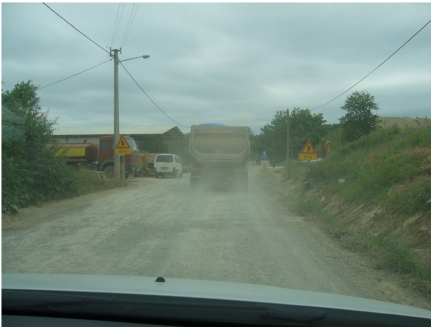
Слика 7 - Такође честа појава на деоницама изградње аутопута – пример повишене концентрације прашине у ваздуху услед кретања грађевинске механизације приступним путевима (непосредна близина позајмишта „Провалије“, деоница Обреновац - Уб, Сектор I аутопута Е – 763)
