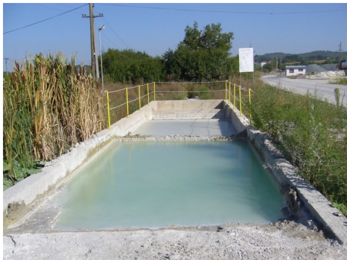
Слика 5 - Пример добре инжењерске праксе у заштити животне средине - Базен са таложником за прање миксера за бетон на градилишној бази једног од Подизвођача радова (Енергопројект – Београд) на деоници Лајковац – Љиг, Сектор I аутопута Е – 763.
