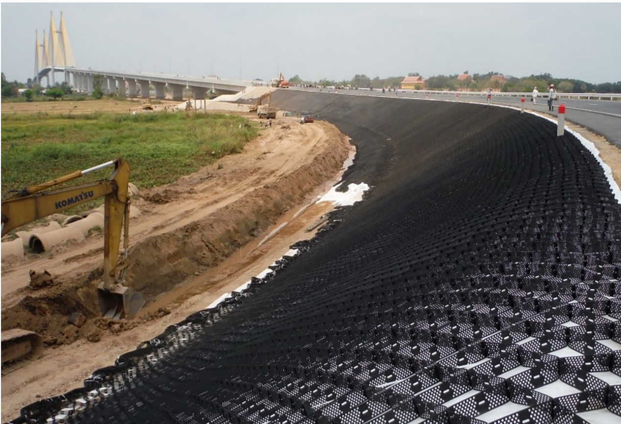
Slika 3. Stabilizacija kosina na prilaznoj konstrukciji mosta primenom trodimenzionalnih saća (Izvor: L.4)
