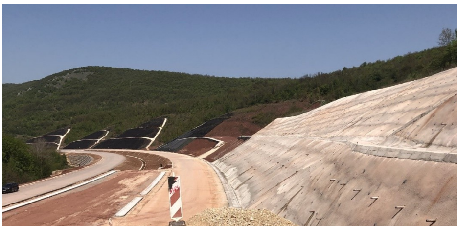
Slika 8. Primeri neuspešnog uklapanja puta u postojeći teren [privatna arhiva]
