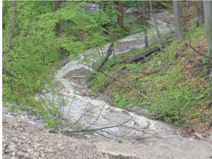
Слика 3 - Испирање миксера за бетон директно у јаругу на деоници Лајковац – Љиг у непосредној близини моста бр. 16 и тунела „Бранчић“, Сектор I
