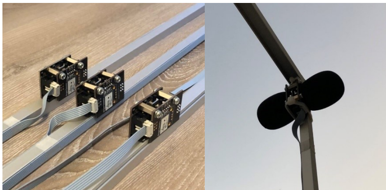
Slika 8. Mikrofonski moduli montirani na rešetku Izvor: (Autori)
