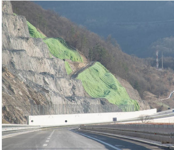
Slika 9. Primeri neuspešnog uklapanja puta u postojeći teren [7]
