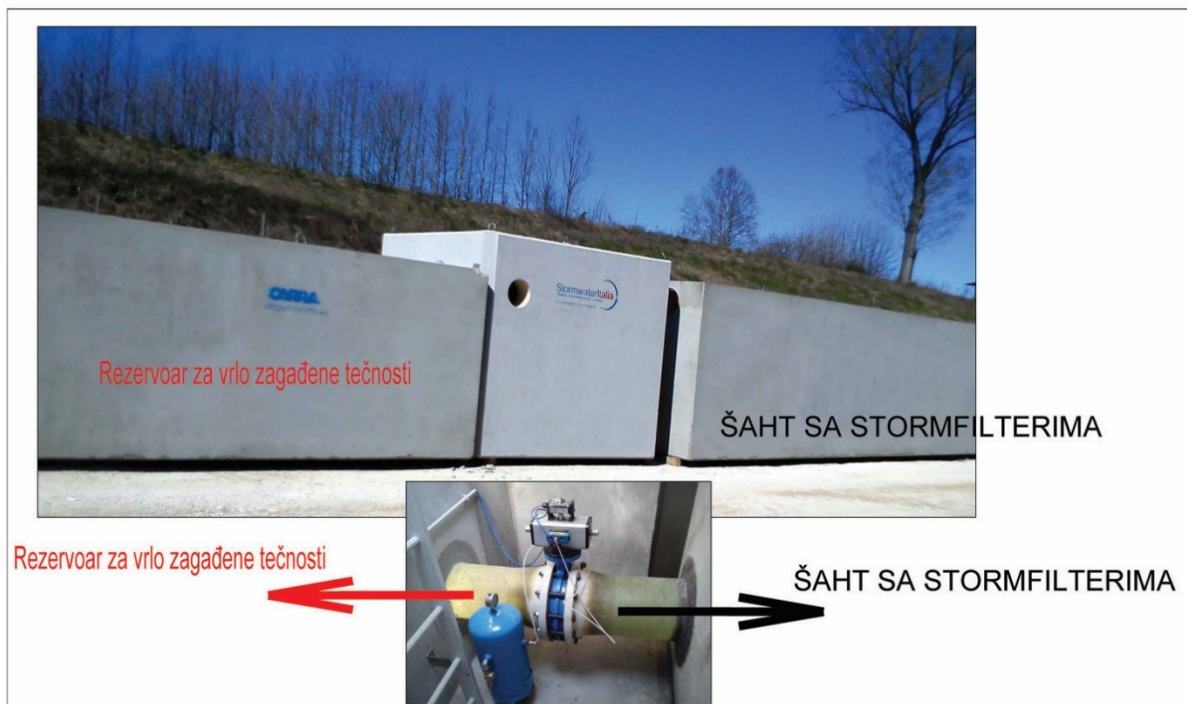
Slika 4. Izgled prefabrikovanih objekata za kompleksno tretiranja kanalisanih kišnih voda na Auto-putu E – 80, na krajnjoj deonici u Srbiji do bugarske granice
