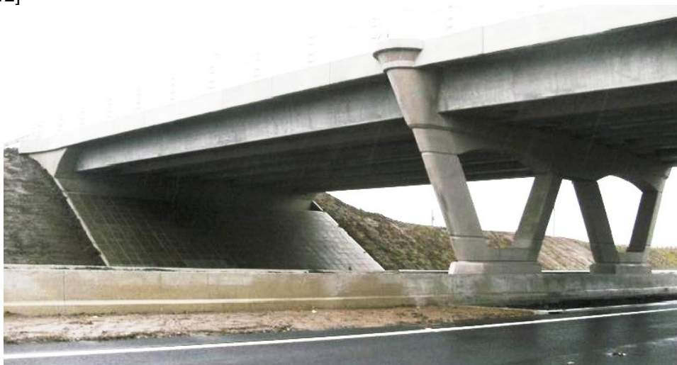
Slika 6. Izgled jedno betonskog integralnog mosta
