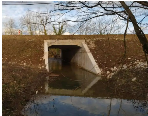
Slika 11. Propust za životinje i za propuštanje potoka Izvor: ekoportal.me
