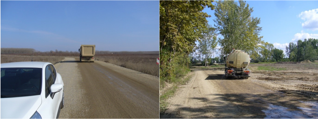
Слика 8 и 9 - Не тако честа појава на свим деоницама изградње аутопута у Србији – орошавање приступних путева градилишту у зони моста преко реке Саве, деоница Кузмин – Сремска Рача
