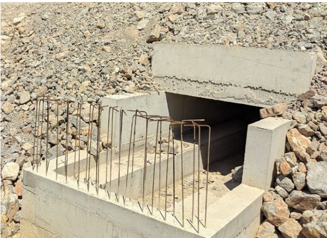
Slika 7. Izgradnja eko-prelaza za životinje Izvor: E3 Consulting
