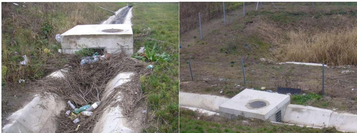
Слике 12 и 13 - Систем одвођења атмосферске воде са коловоза до ретензија на деоници Сурчин – Обреновац изграђеног аутопута „Милош Велики“.
