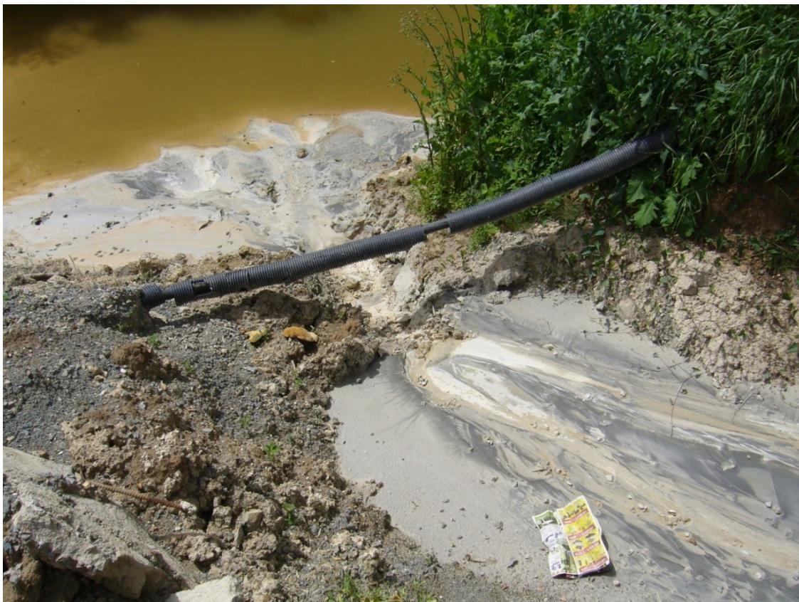
Слика 2 - Пример загађивања реке Лесковице, речне обале и седимента речног дна. Водоток протиче ободом грађевинског кампа – загађење потиче од испирања миксера за бетон у канал који одводи отпадну воду у водоток без сепаратора и пречишћивача.
