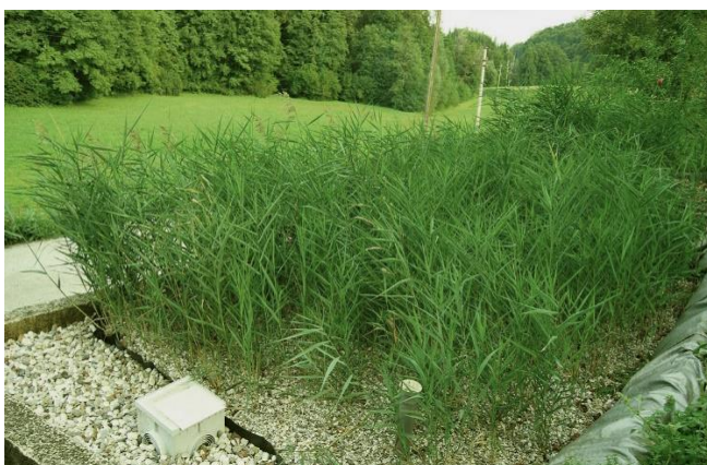
Слике 4: Биљни уређаји за пречишћавање отпадних вода природно су, ефикасно и робусно решење за пречишћавање отпадних вода из индивидуалних кућа и насеља. (Фото и Shema: LIMNOS d.o.o)
