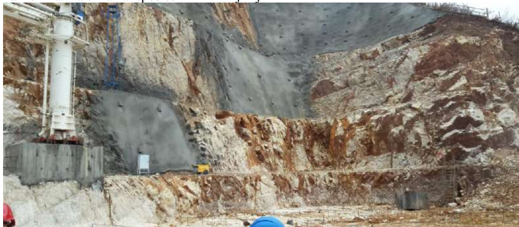
Temeljna jama sa zaštitom iskopa stuba P5
