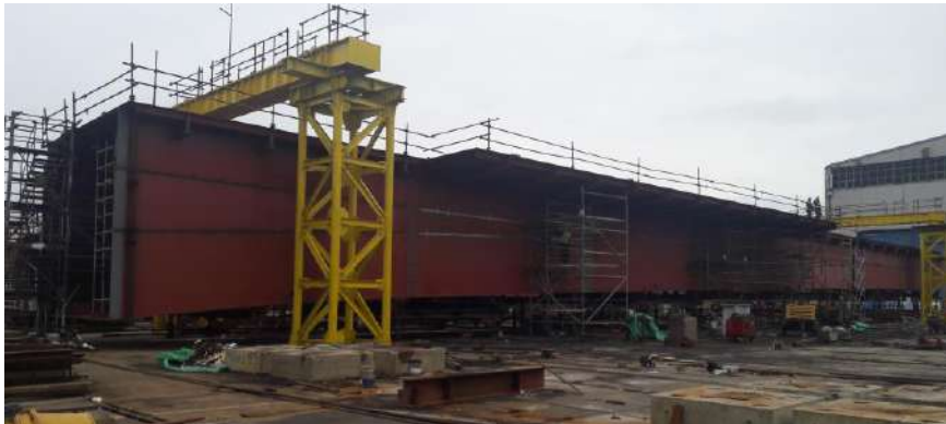
Slika 3a – Montaža jedne od sekcija mosta u brodogradilištu
