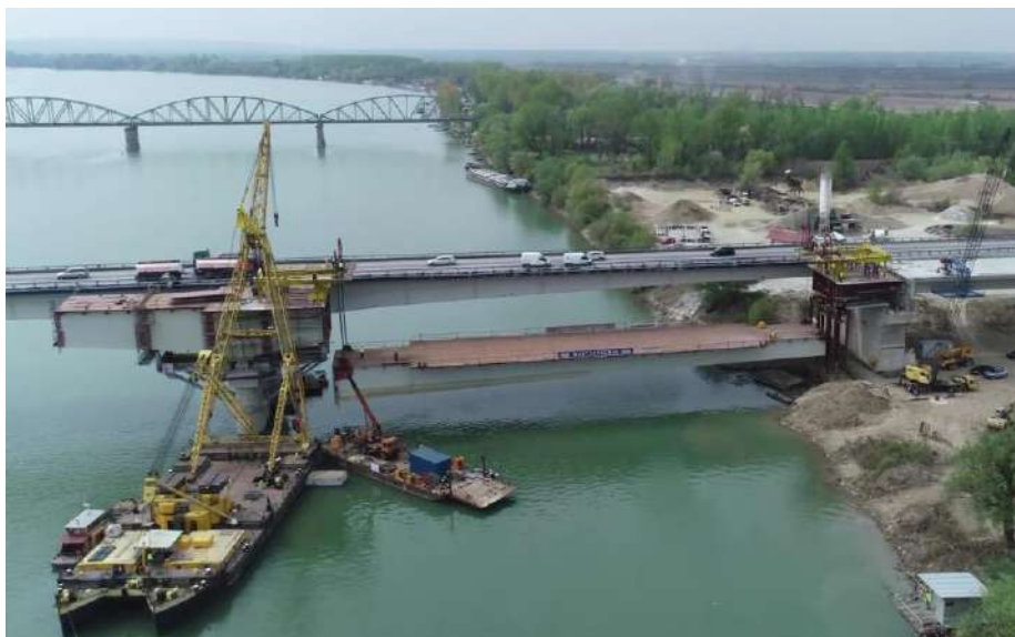
Slika 4 - Podizanje segmenta S1–S2
