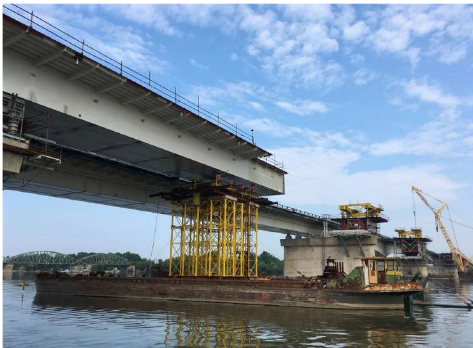
Slika 2 - Segment S4–S6 tokom podužnog prevlačenja
