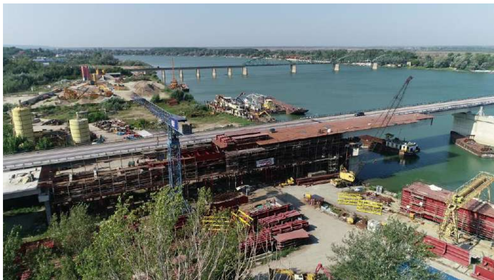
Slika 1 - Prva faza podužnog prevlačenja segmenta S4–S6
