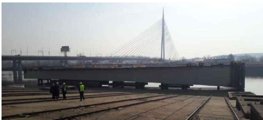
Slika 3b – Jedna od sekcija mosta neposredno pred porinuće u reku
