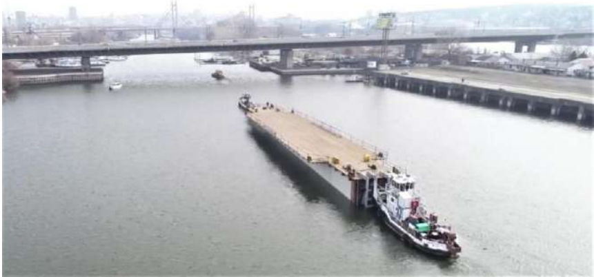
Slika 3d - Rečni transport jedne od sekcija mosta
