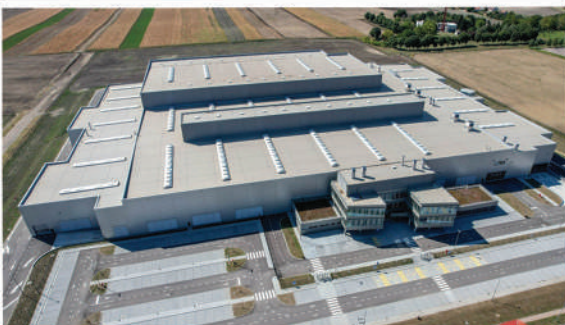
INDUSTRIJSKI OBJEKTI / INDUSTRIAL BUILDINGS "Boysen Abgassysteme" doo, Subotica - proizvodnja komponenta za autoindustriju
