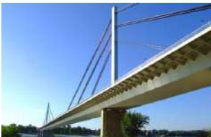
Drumski Most slobode preko Dunava, Novi Sad, 2005. Istog izgleda kao srušeni 1999, ali sa obimnim izmenama i ojačanjima u odnosu na prvobitni most (1980). L_{max} = 351 m
