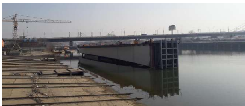
Slika 3c - Jedna od sekcija mosta neposredno posle porinuća u reku
