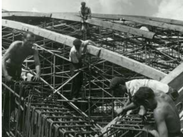
Израда оплате за бетонирање љуске хале
