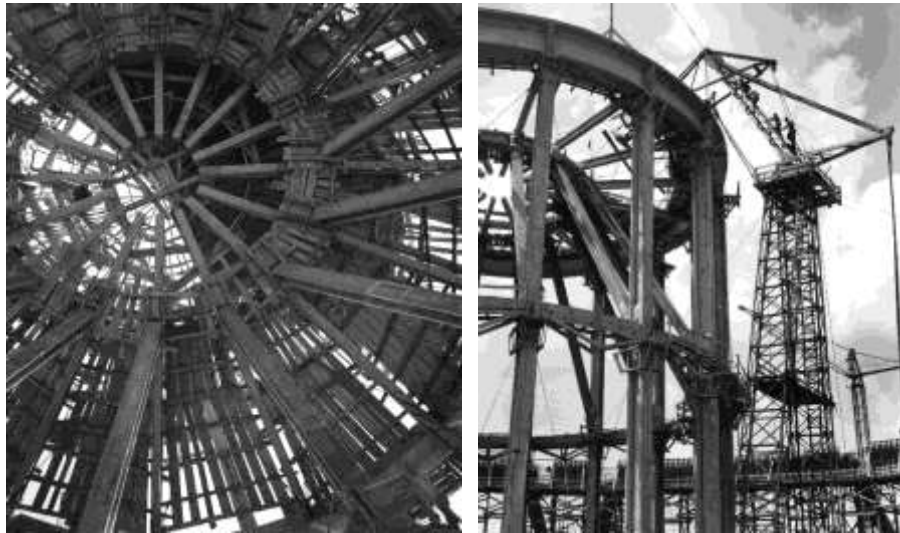
Скела за монтирање носача крова Хале 1
