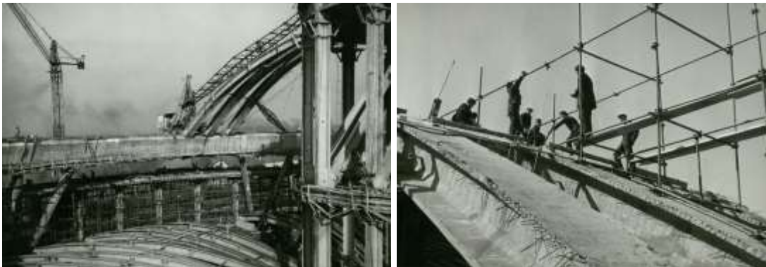
Монтирање кровних носача Хале 1
