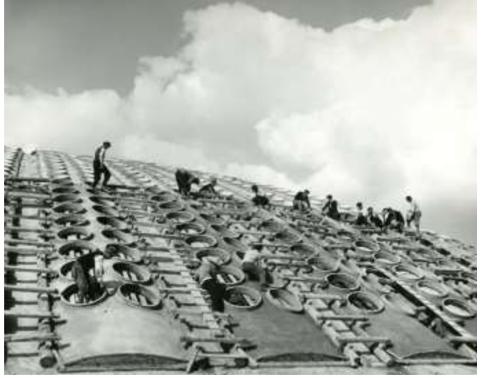
Покривање крова Хале 1
