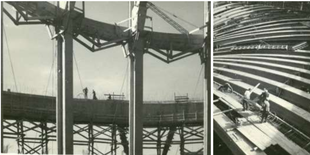
Кровна конструкција Хале 1
